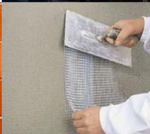
Lepljenje fasadnih plošč in izdelava osnovnega armiranega ometa z Nivefas univerzalnim lepilom
