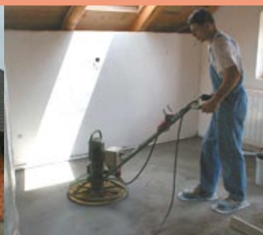
Mikro armirani estrihi Omalt MCE vsebuje polipropilenska vlakna, ki omogočajo izvedbo estriha brez vgradnje dodatne armaturne mreže. To je še posebno dobrodošlo pri izvedbi estrihov v manjših prostorih.
