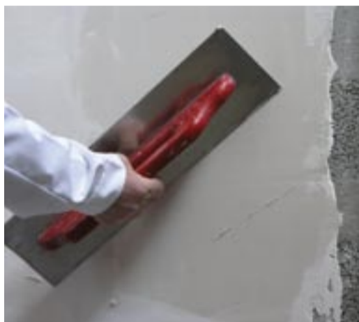
Fina izravnava notranjih površin z Vilaplanom
