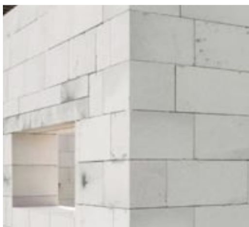
Nivedur M lepilna malta za zidanje z zidaki iz porobetona.
