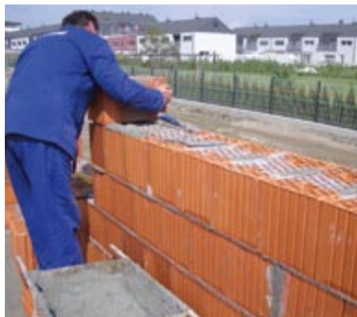
Zidanje z Omalt MzZ M5 malto za zidanje
