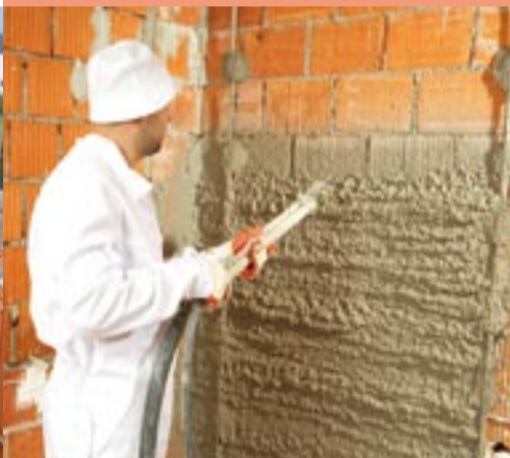
Ometavanje površin z Omalt CASO strojnim ometom
