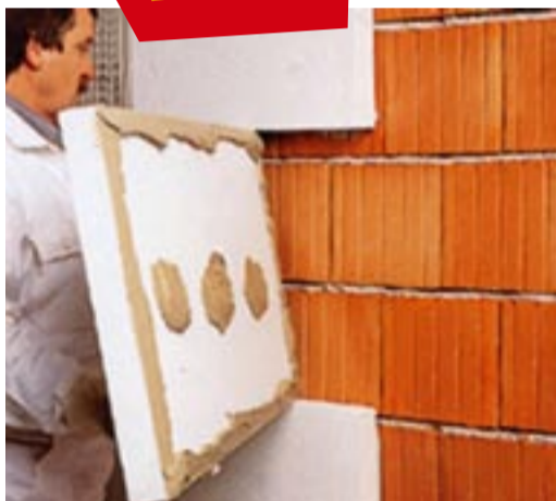
Lepljenje fasadnih plošč in izdelava osnovnega armiranega ometa z Nivefas univerzalnim lepilom
