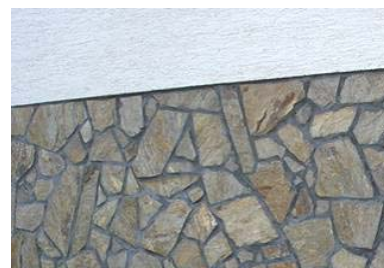
Fasadni podzidek iz skrilavca
