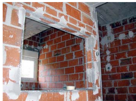
Pred ometavanjem vgradimo vogalne zaščitne letve
