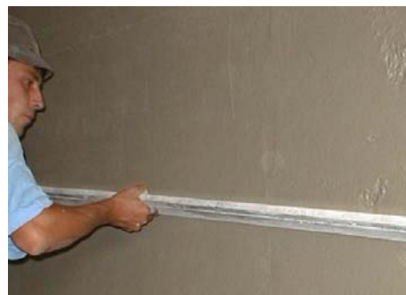
Ometni sloj posnamemo (porežemo) in poravnamo
