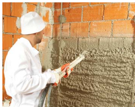
Malto nanašamo v goseničastih vrstah v enakomerni debelini
