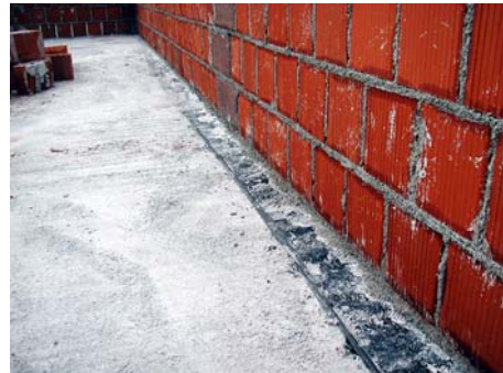
Opečne fuge morajo biti zapolnjene, zidaki ne smejo izstopati
