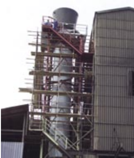
Priprava priključkov na obstoječi čistilni napravi za vgradnjo šob za dodatno čiščenje razklopnih plinov
