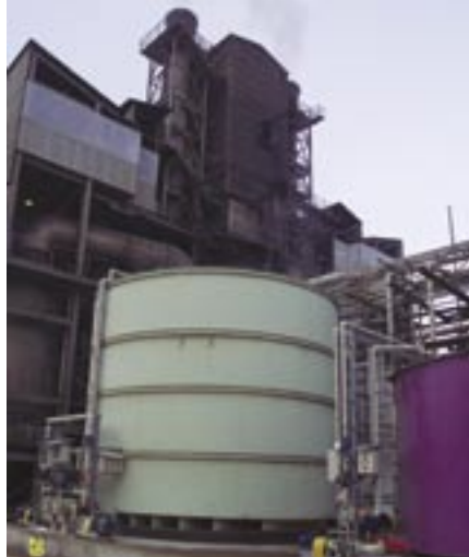
Del čistilne naprave za pripravo in razprševanje absorpcijskega sredstva
