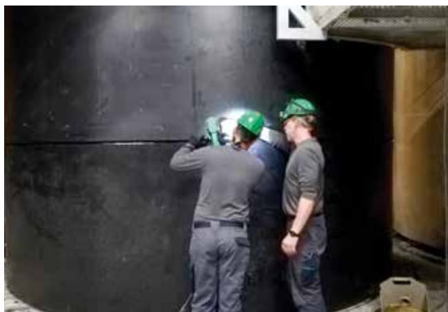
Varjenje obročev na lokaciji.
