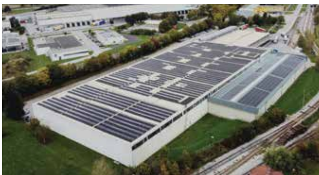
Sončna elektrarna na obnovljeni strehi skladišča Marketinga z instalirano močjo 1,3 Mwp.
