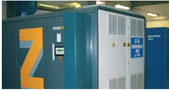
Novi frekvenčno regulirani kompresor za proizvodnjo 7,5 barskega zraka
